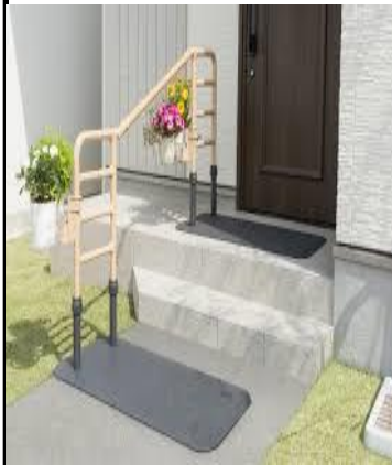
玄関へ手すり 設置
